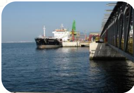
Integridad de terminales y puertos
